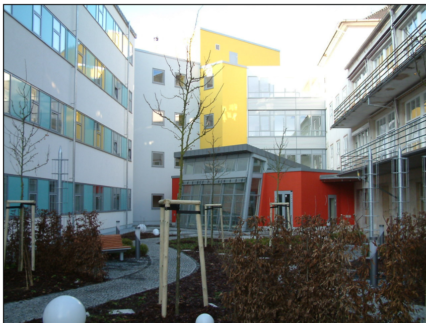
Innenhof Kreiskrankenhaus Löbau
