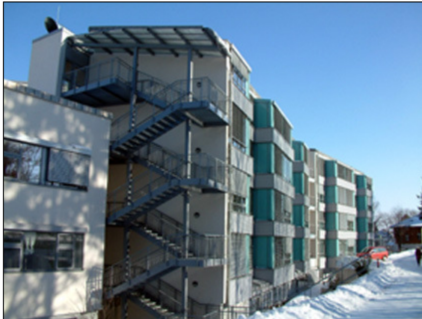
Neubau des Kreiskrankenhauses Löbau
