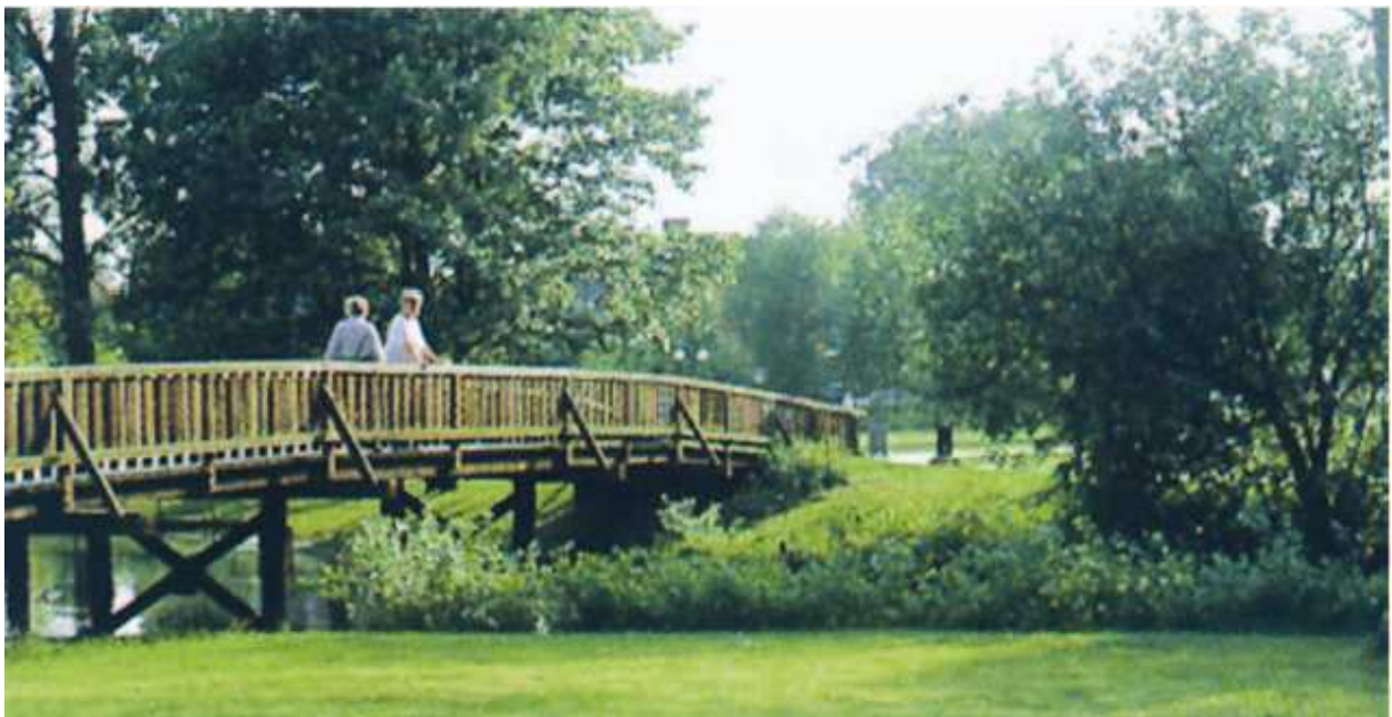
Brücke des Stadtparks Munster nahe der Altus-Klinik
