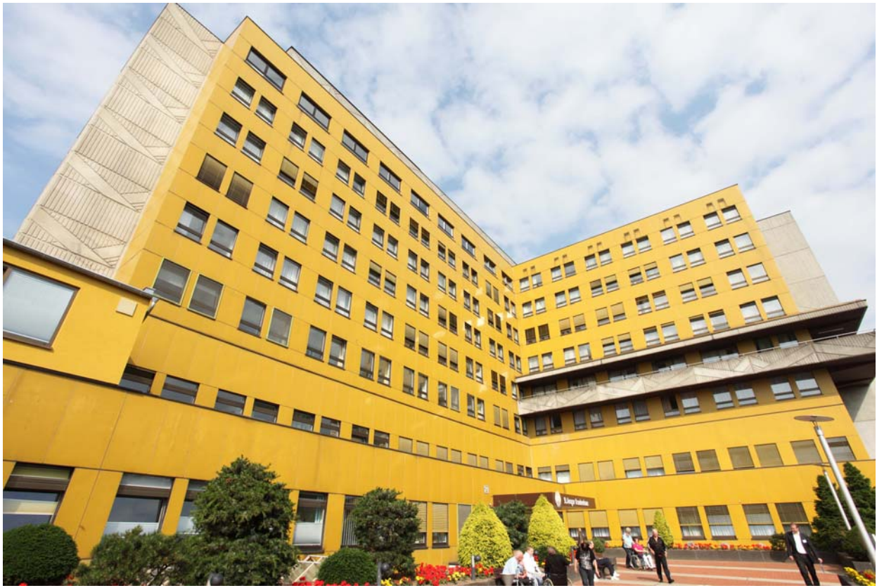
Ansicht: St. Ansgar Krankenhaus, Höxter
