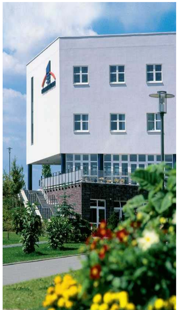
Abbildung: Blick auf den Eingangsbereich und die Cafeteria der Pleißenal-Klinik GmbH
