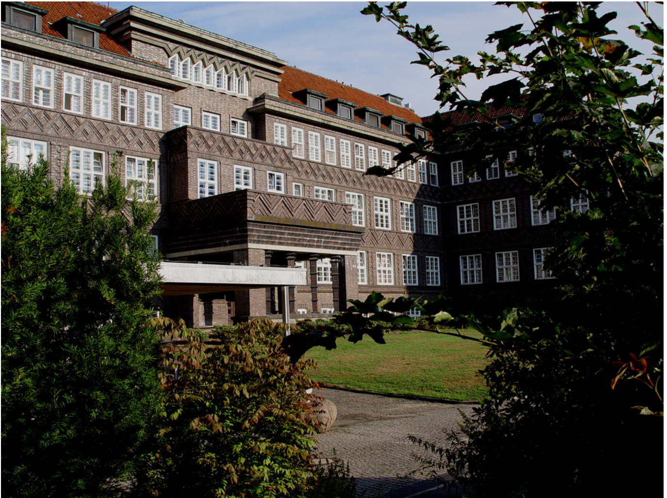
Abbildung: Der ehemalige Haupteingang des Klinikums
