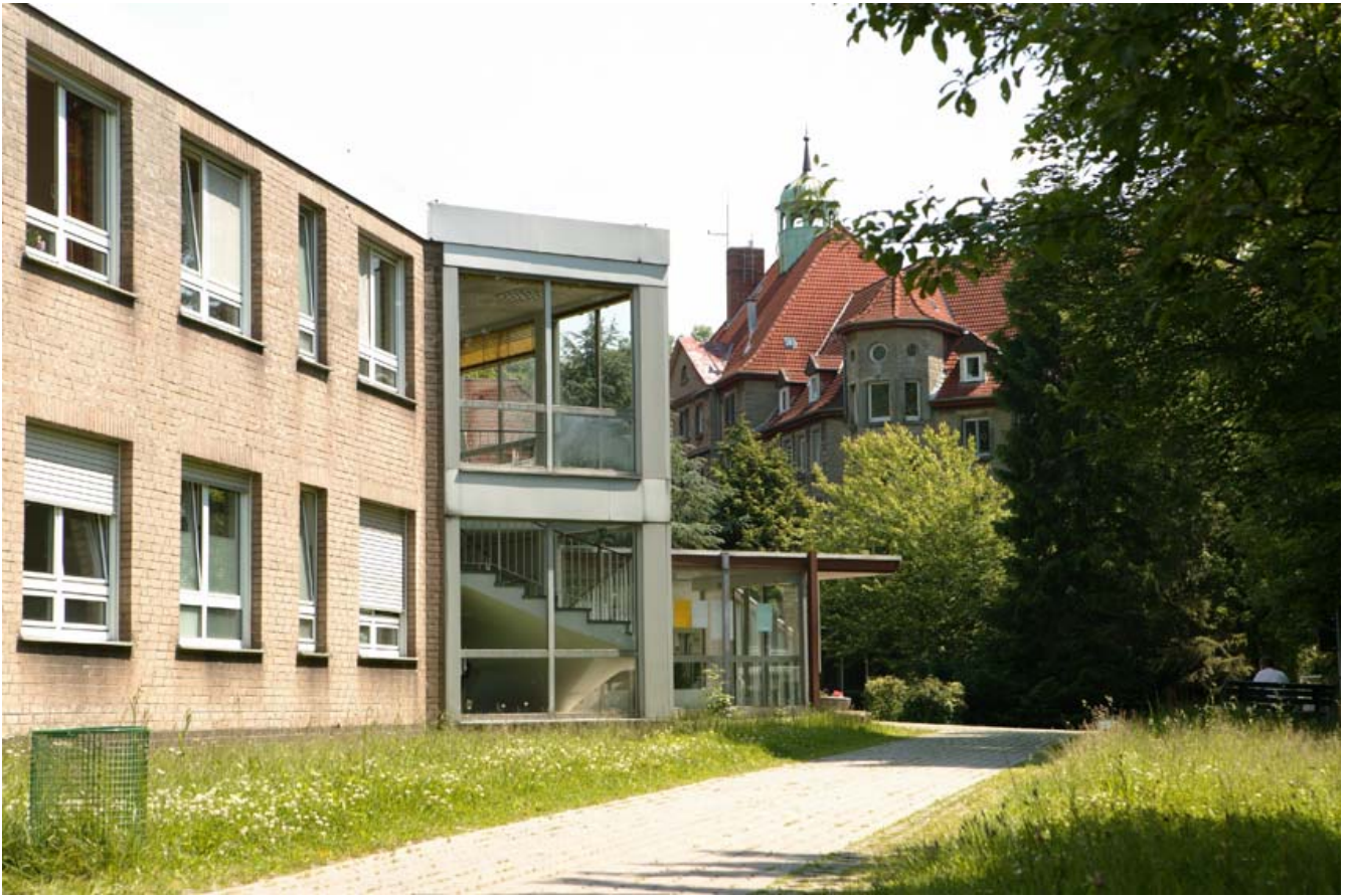
Abbildung: Bettenhaus mit Versorgungsgang zum Altbau, in dem die diagnostischen Abteilungen, die Radiologie und das Medizinische Versorgungszentrum untergebracht sind.
