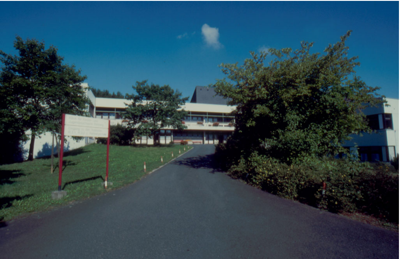
Abbildung: Haupthaus der Klinik mit 3 Stockwerken in Hanglage
