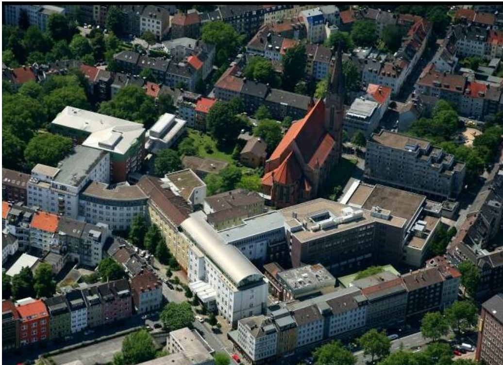
Luftaufnahme des St.-Johannes-Hospitals Dortmund
