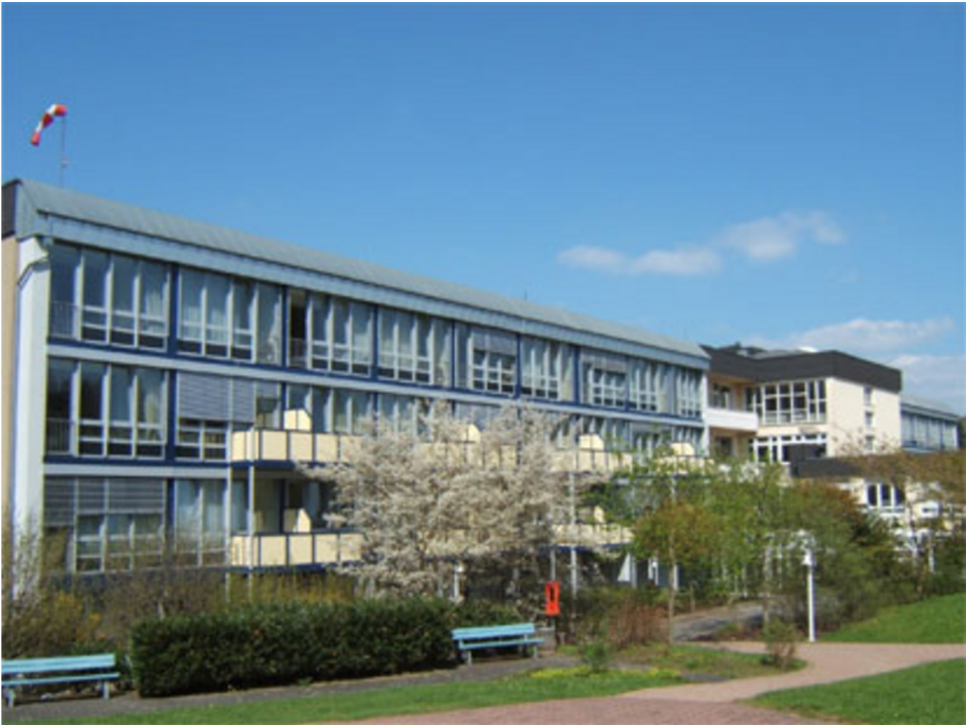
Abbildung: Krankenhaus Maria Hilf in Warstein
