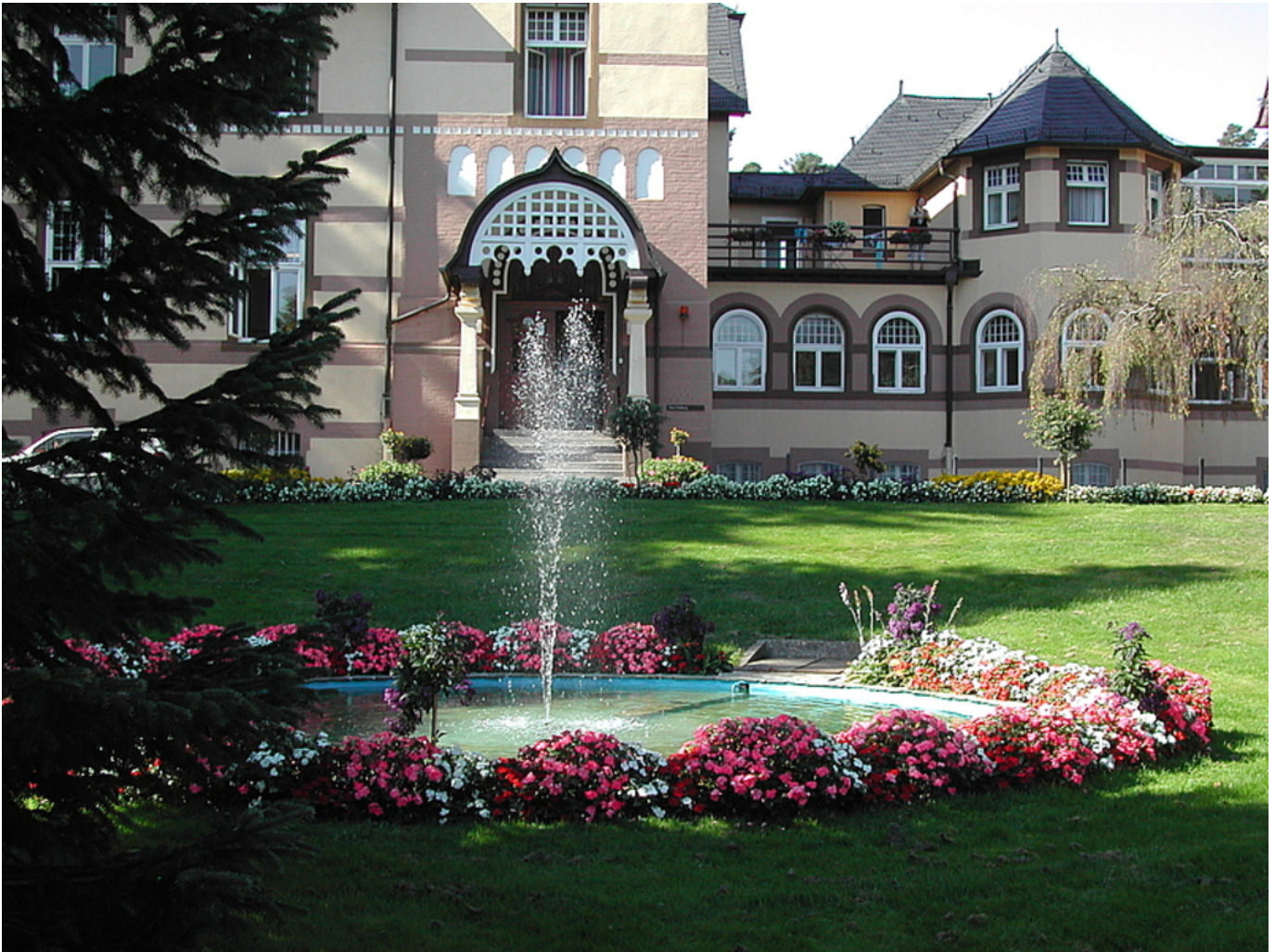
Abbildung: Eingang des historischen Teils der Klinik Hohe Mark
